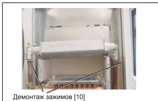
Рисунок: Демонтаж теплообменника сетевой воды
